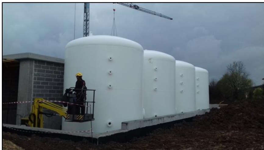
Figura 5.2: Particolare dei nuovi filtri forniti.
