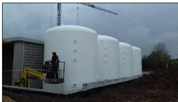
Figura 5.2: Particolare dei nuovi filtri forniti.
