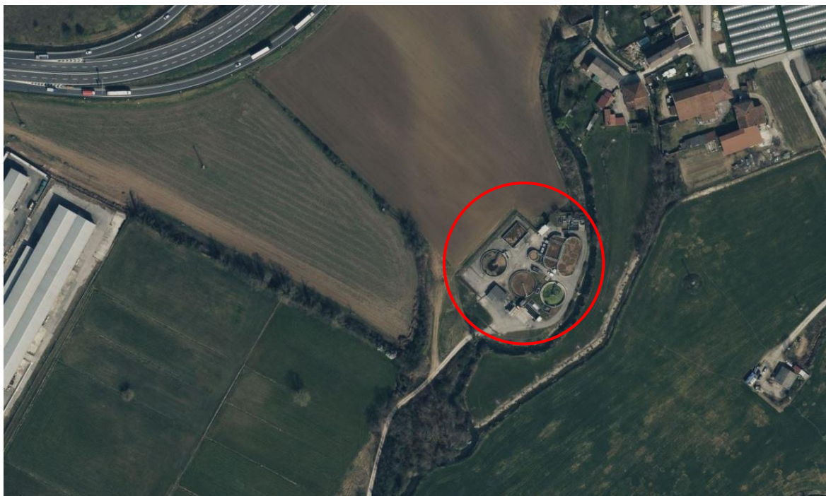
Figura 2.3. Dettaglio della vista aerea del depuratore di San Martino Buon Albergo (VR).
