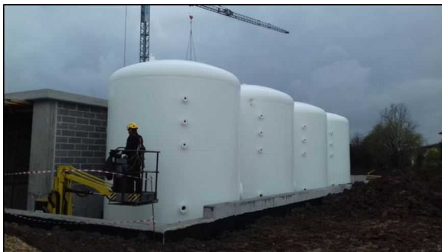
Figura 5.2: Particolare dei nuovi filtri forniti.
