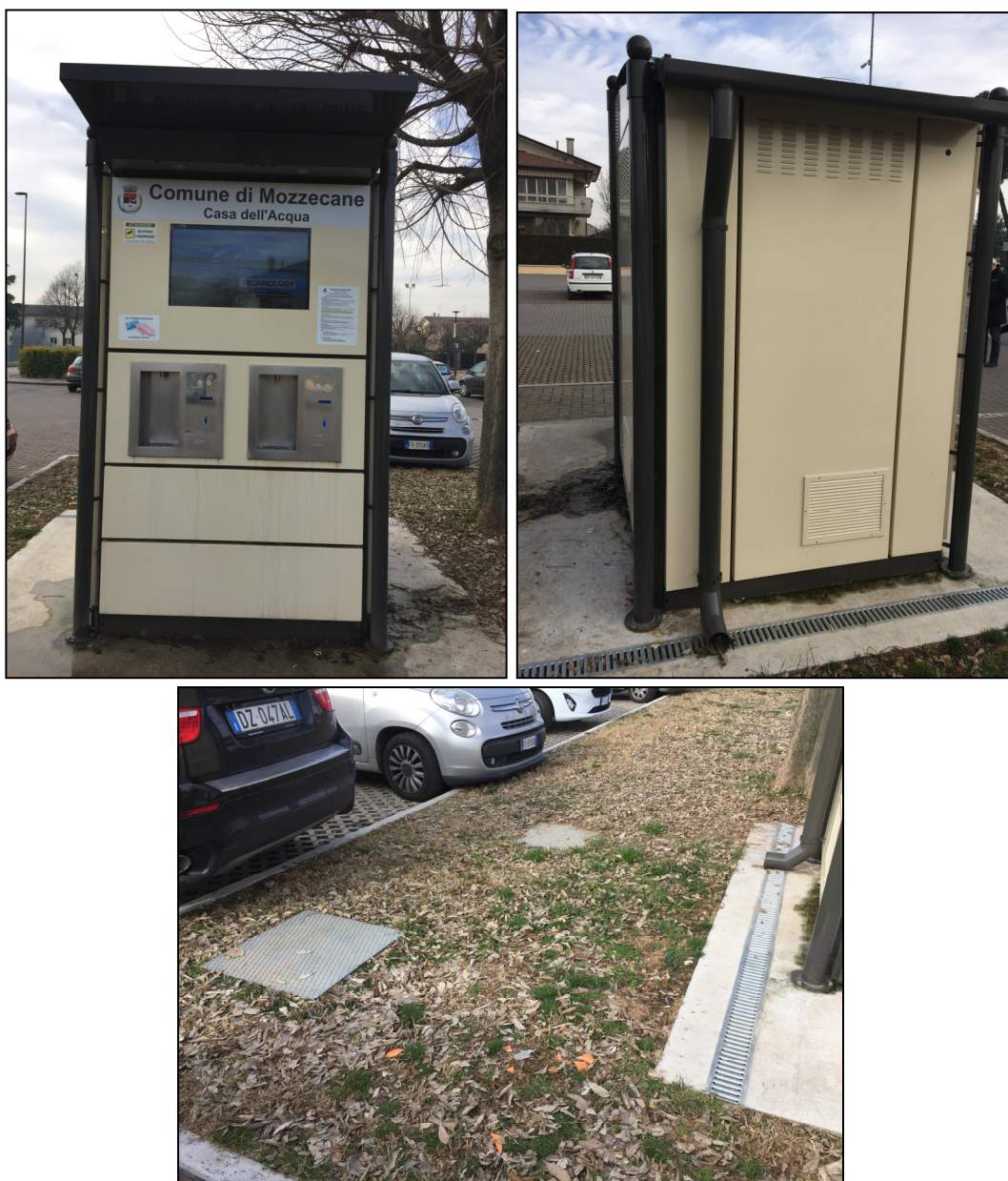
Figura 1: dettaglio "Casa dell'Acqua" in comune di Mozzecane in via G. Ferroni
