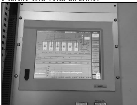
Figura 7: Telecontrollo presso l'impianto
