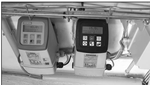
Figura 1: Misuratori di portata presso i due pozzi siti in viale Venezia - Peschiera del Garda
